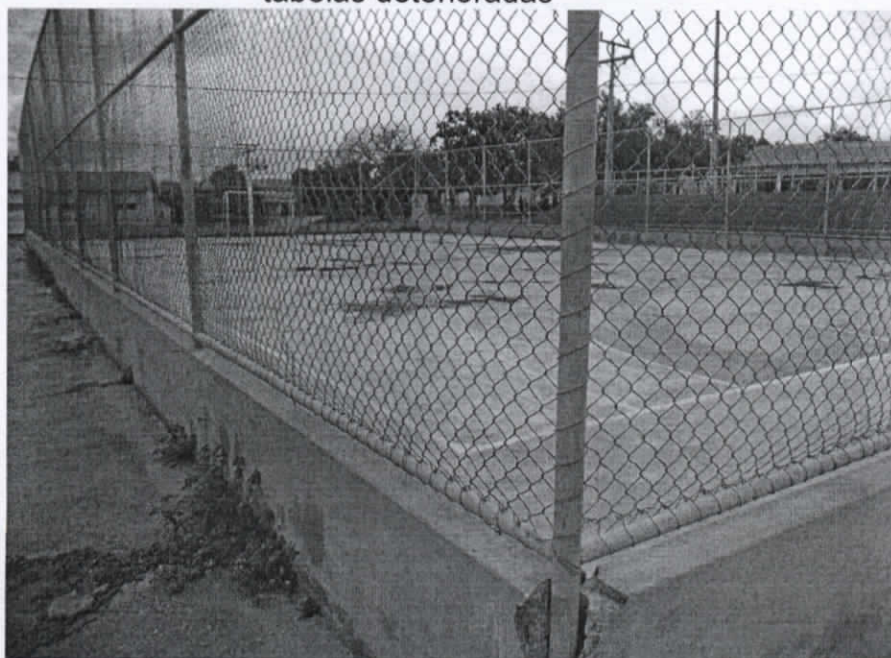
Figura 07 – Pintura de piso da quadra, mureta, alambrados, traves e tabelas deterioradas
