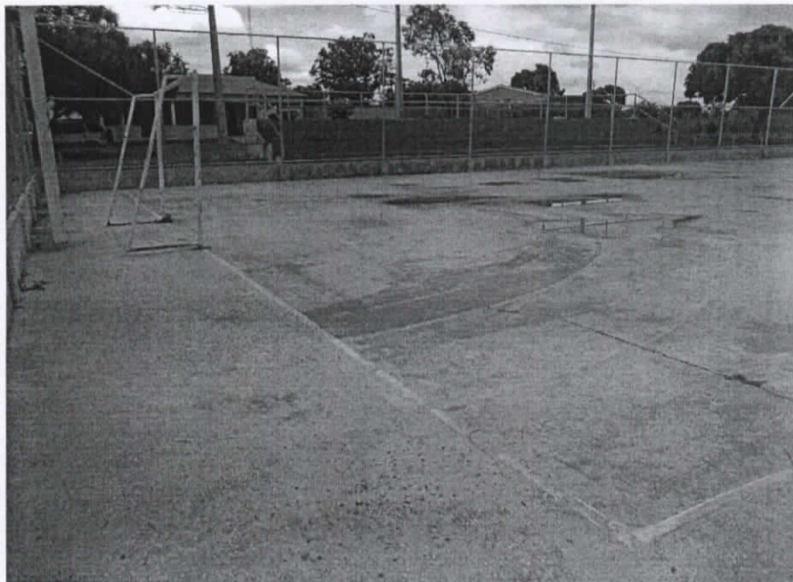
Figura 07 – Pintura de piso da quadra, mureta, alambrados, traves e tabelas deterioradas
