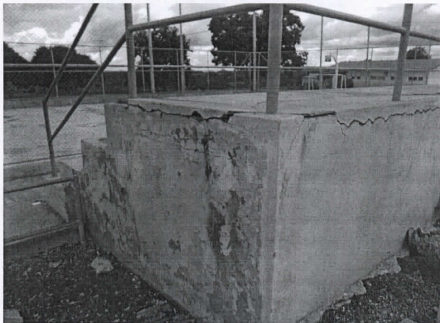
Figura 03 – Reboco das laterais da arquibancada deteriorado
