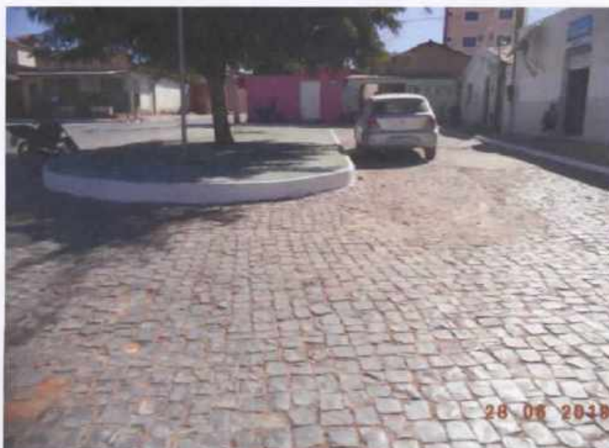
Fotografia 63 – Rua Pedro Estrela 02
