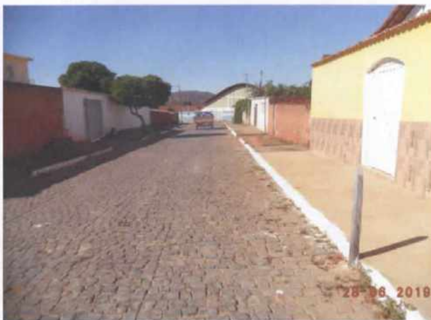
Fotografia 52 – Rua São Pedro Trecho 01 e 02
