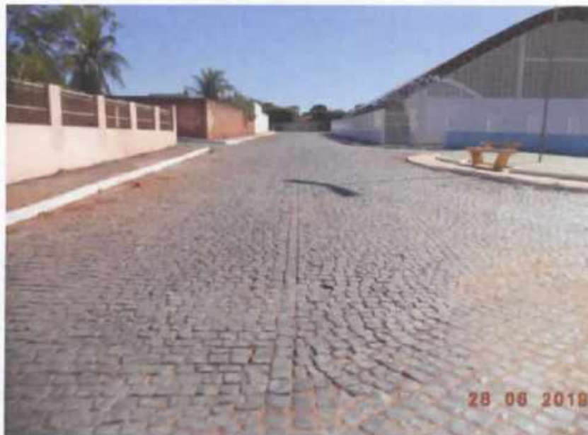
Fotografia 54 – Rua São Pedro Trecho 01 e 02
