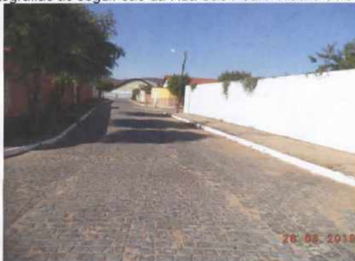
- Fotografia 51 – Rua São Pedro Trecho 01 e 02
