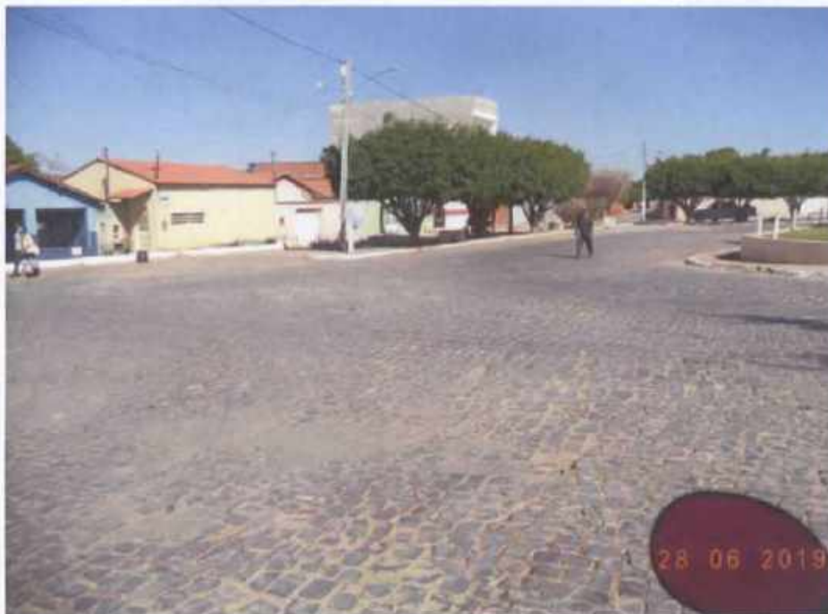
Fotografia 64 – Rua Pedro Estrela 03
