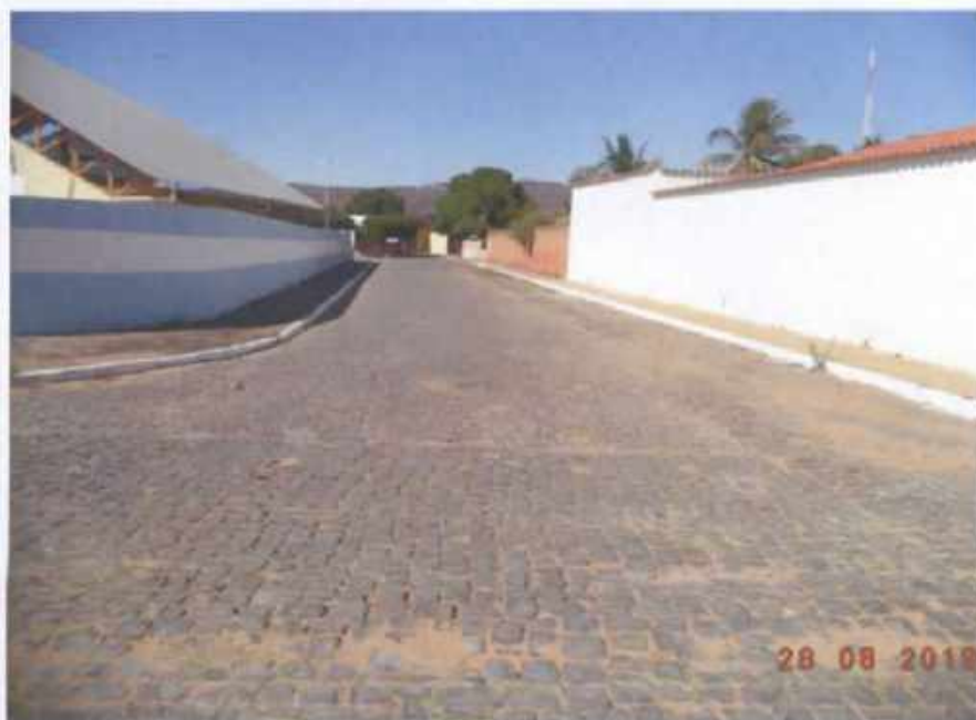
Fotografia 53 – Rua São Pedro Trecho 01 e 02
