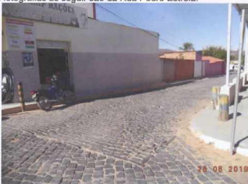
Fotografia 62 – Rua Pedro Estrela 01
