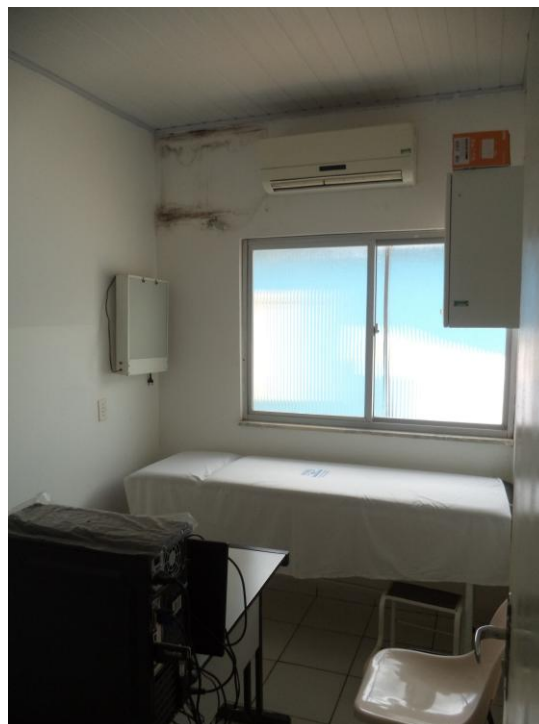
Figura 06 – Parede Manchada
