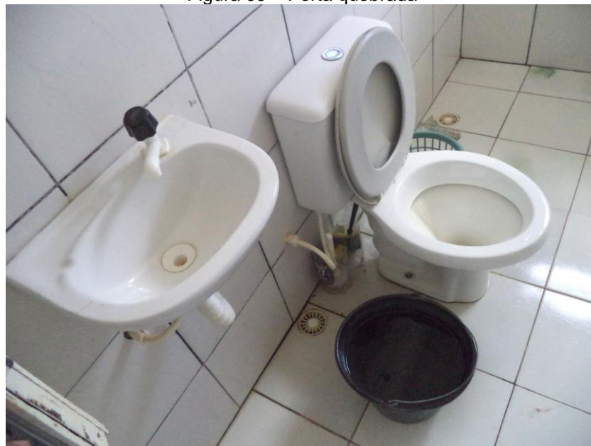
Figura 10 – Lavatório com torneira frágil
