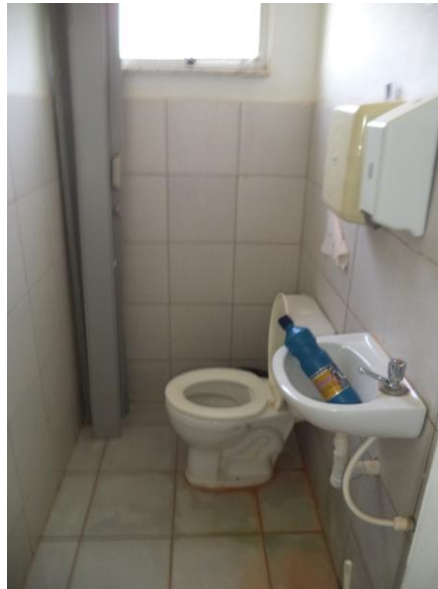
Figura 09 – Porta sanfonada quebrada
